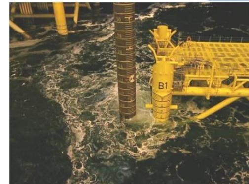
於風機基礎打樁導架上及離岸變電站水下基礎結構上，設置內建之局部氣泡幕加強減噪效果
