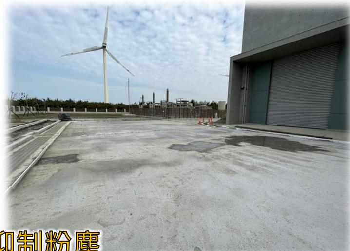
工區裸露地鋪設鋼板/級配/防塵網/混凝土抑制粉塵
