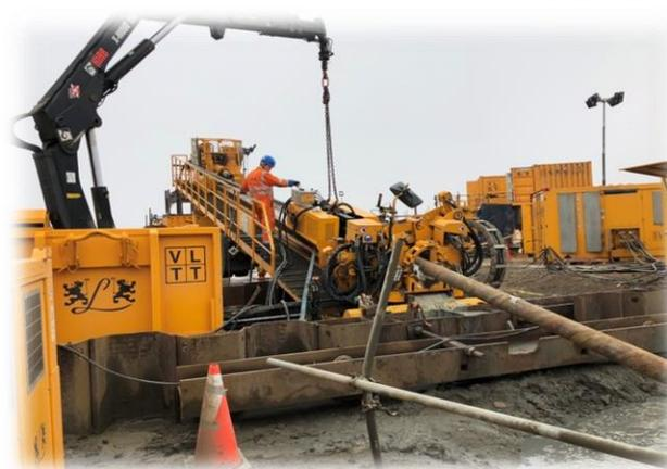
HDD(水平導向式潛鑽)地下工法
