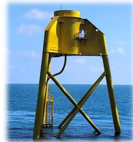
▲ 水下基礎安裝
