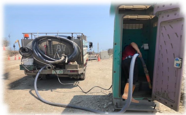
流動廁所定期委託合格代清除處理業處理
