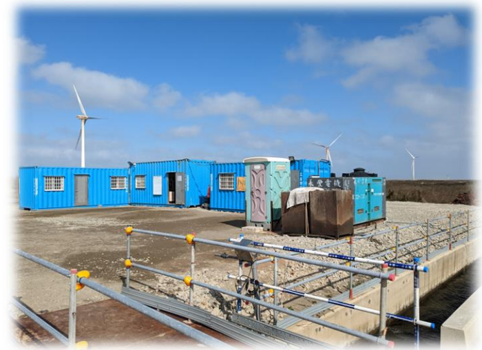
▲ 陸域自設(升)降壓站工區現況
