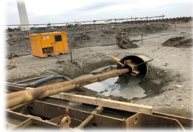
HDD(水平導向式潛鑽)地下工法
