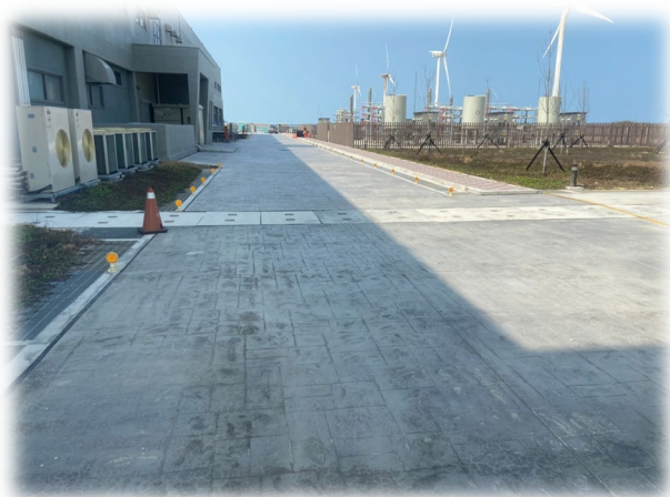
鋪設混凝土抑制粉塵
