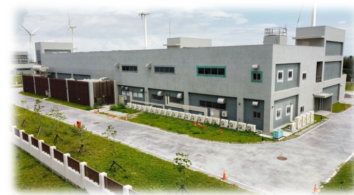
▲ 陸域自設(升)降壓站施作
