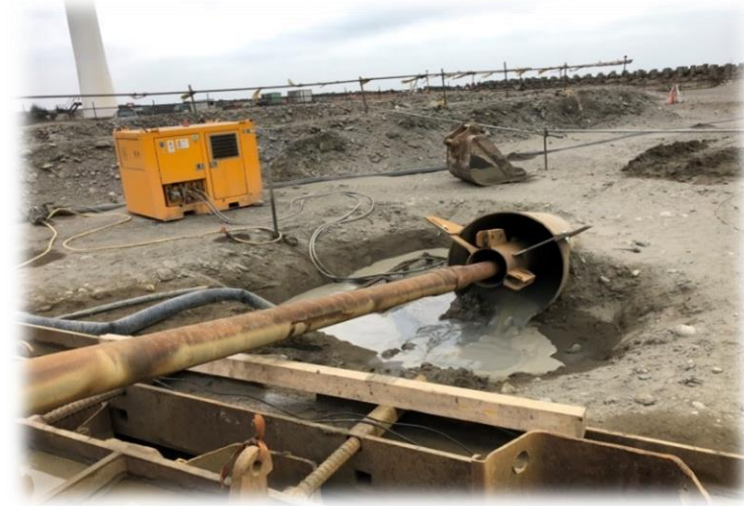
HDD(水平導向式潛鑽)地下工法
