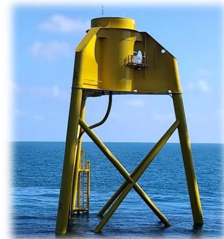
▲ 水下基礎安裝
