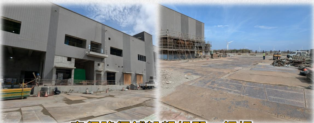
車行路徑鋪設粗級配、鋼板
