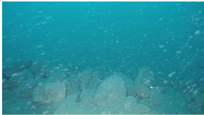
圖2.1-2 西南風場營運期間基樁拋石水下攝影結果
