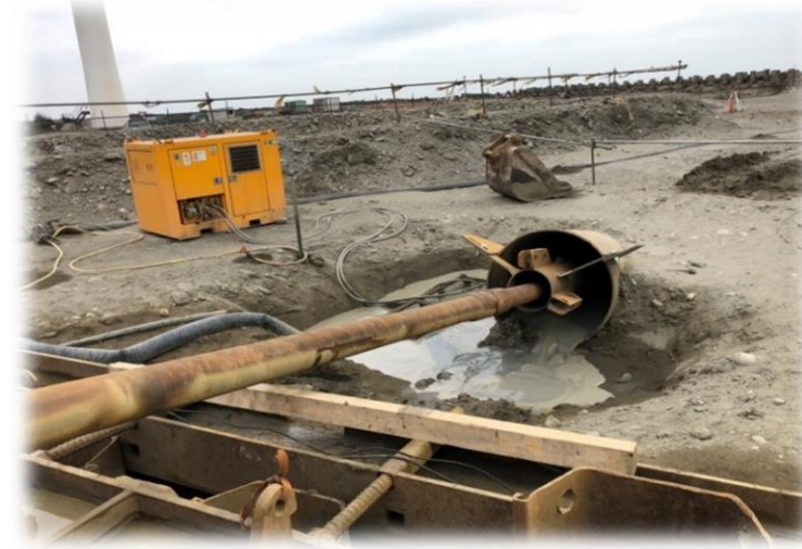
HDD(水平導向式潛鑽)地下工法
