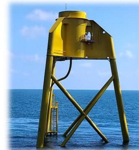
▲ 水下基礎安裝
