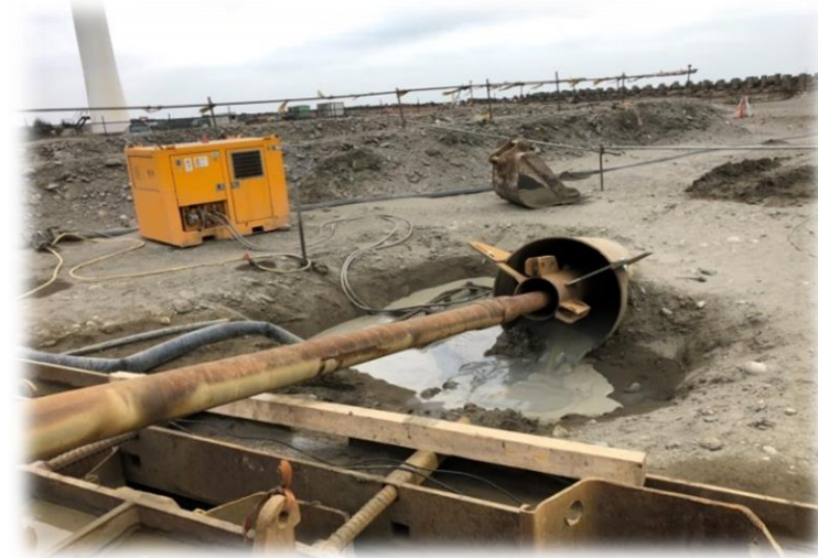
HDD(水平導向式潛鑽)地下工法
