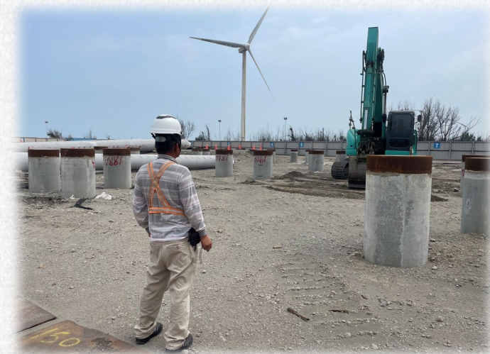
▲ 陸域自設(升)降壓站工區現況
