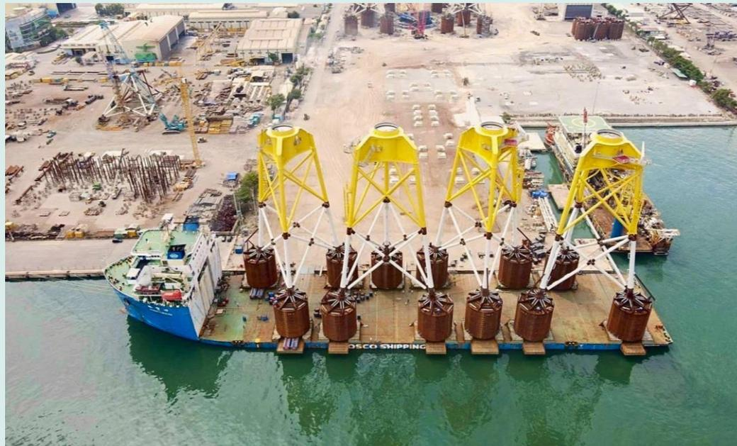
本計畫壓沉箱管架式水下基礎目前已由供應商夥伴製造中，首座負壓沉箱管架式水下基礎已於今年5月完成，其大型構件包含轉接段、水下基礎以及負壓沉箱，預計將於今年年底前全數完成製造，並預計於明年(2025)第一季末陸續進行運輸及安裝作業。
