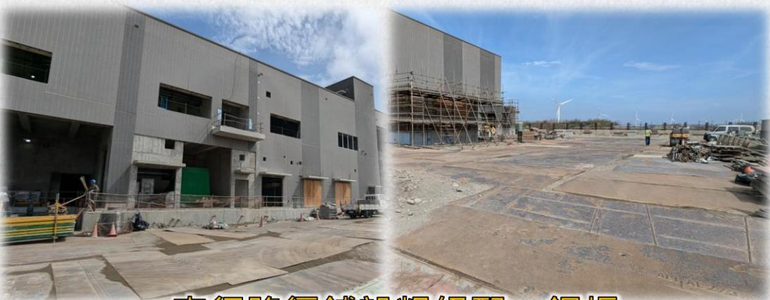
車行路徑鋪設粗級配、鋼板
