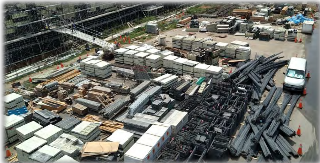
施工材料定點置放
