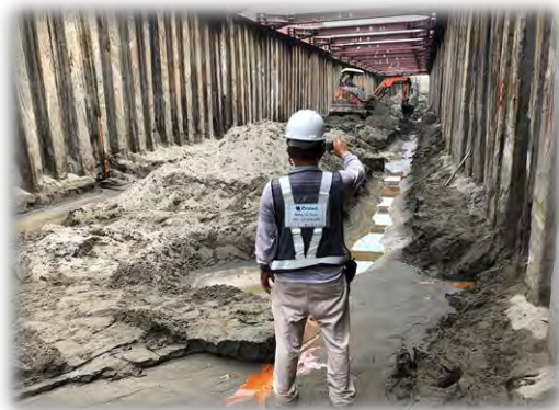
現場監看作業
