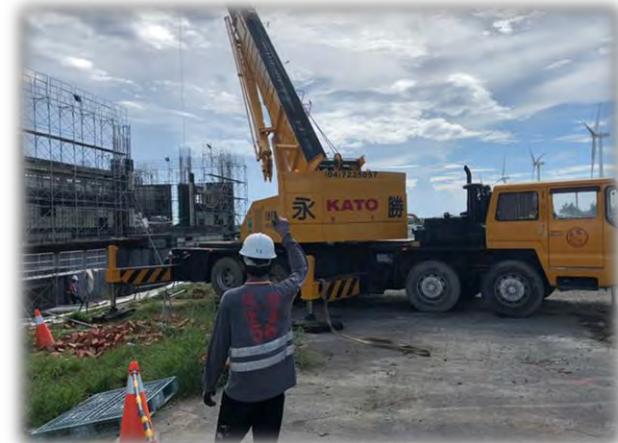
吊裝作業管制
