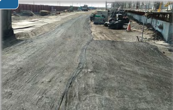
工區裸露地鋪設鋼板/級配/防塵網抑制粉塵
