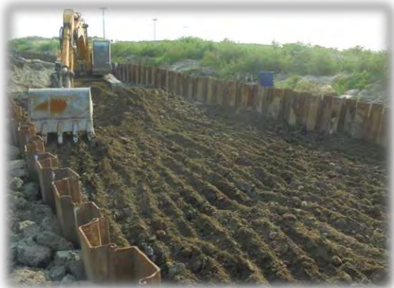
陸纜開挖工程
