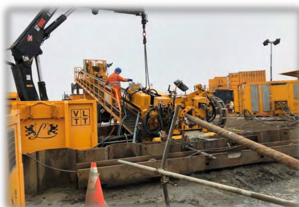
HDD(水平導向式潛鑽)地下工法
