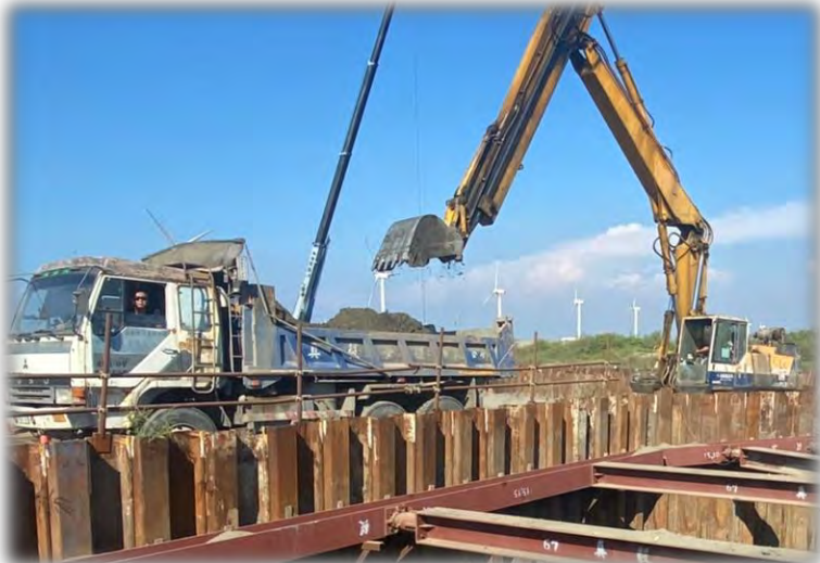
卡車靠近開挖機具減少噪音
