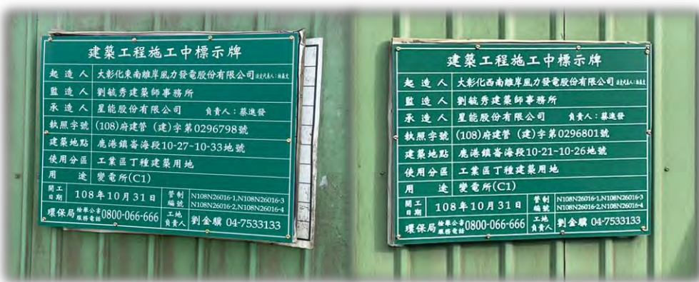
工程告示牌設置
