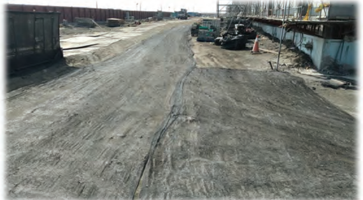
鋪設防塵網抑制粉塵
