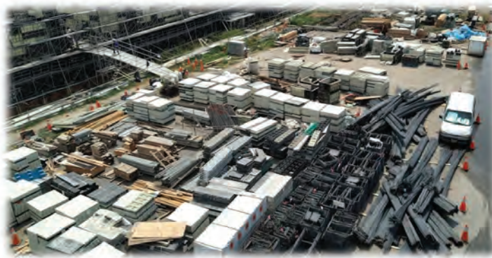
施工材料定點置放
