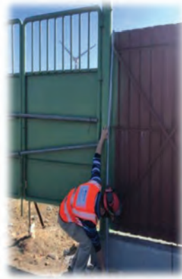
圍籬及防溢座設置
