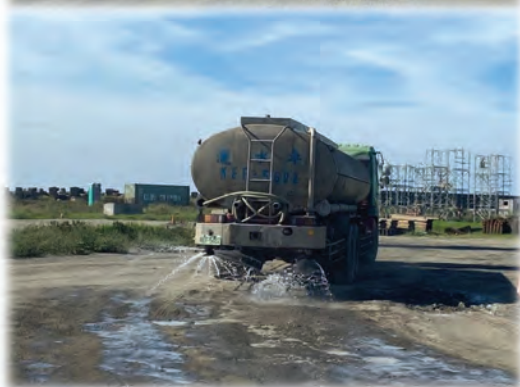
施工工區適度灑水抑制揚塵
