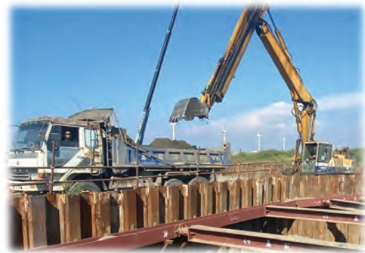
卡車靠近開挖機具減少噪音
