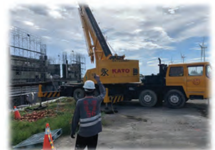
吊裝作業管制
