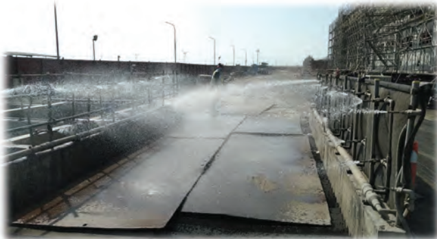
工區出入口設置洗車台
