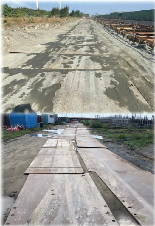
鋪設鋼板抑制粉塵
