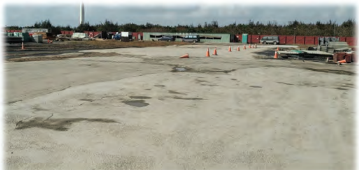
鋪設混凝土抑制粉塵
