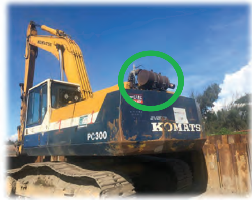
開挖機具加裝濾煙器
