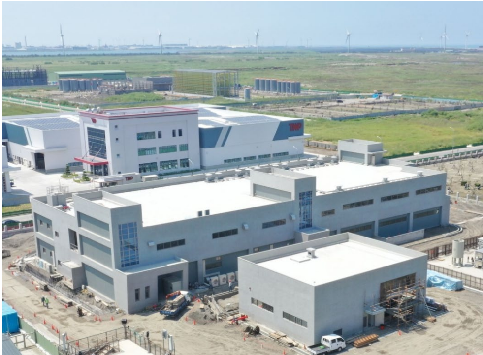
圖 4.1.5-3 本計畫第一階段陸域自設升(降)壓站現況照片
