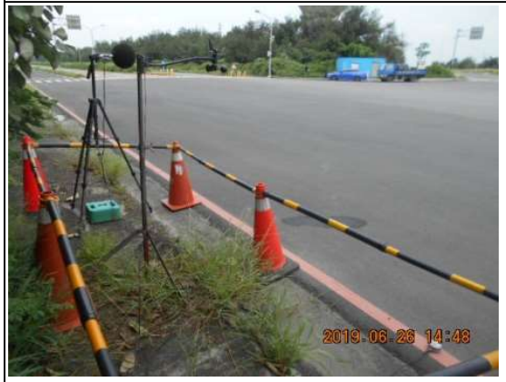
噪音振動：陸域工程進/出道路(108.06.25~26)
