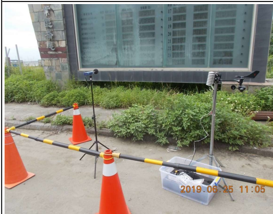
營建噪音：陸域自設升(降)壓站工地周界(108.06.25)
