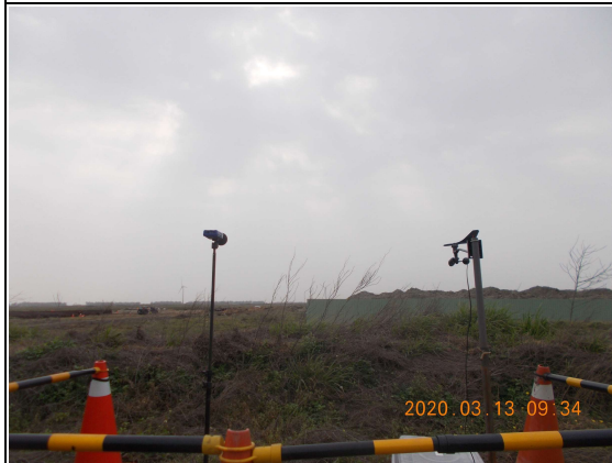
營建噪音：陸纜工地周界(109.03.13)
