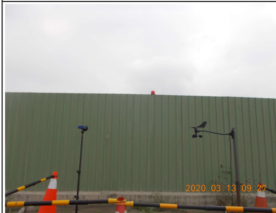
營建噪音：陸域自設升(降)壓站工地周界(109.03.13)
