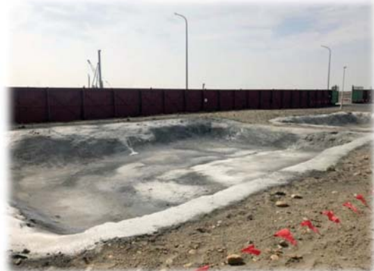
工區內沉砂池設置
