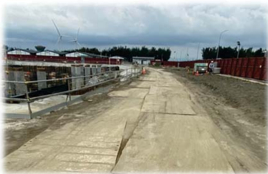
鋪設鋼板抑制粉塵
