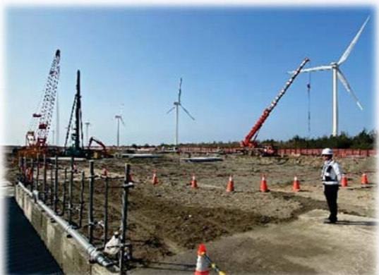
工區作業範圍交通安全管制人員
