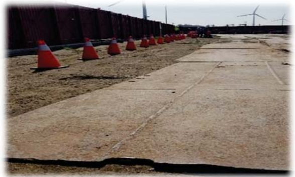
鋪設鋼板抑制粉塵
