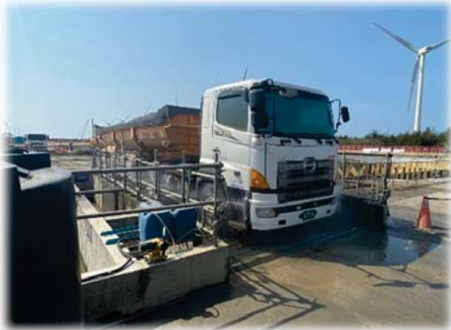
工區出入口設置洗車台
