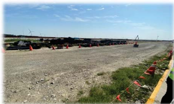
鋪設級配抑制粉塵
