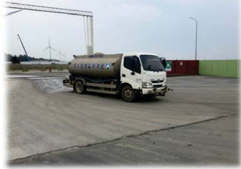
工區內適度灑水抑制揚塵
