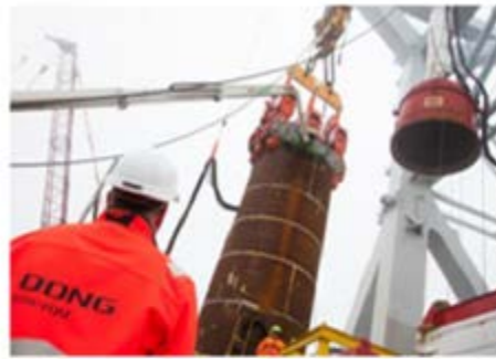
海上打樁作業示意圖
